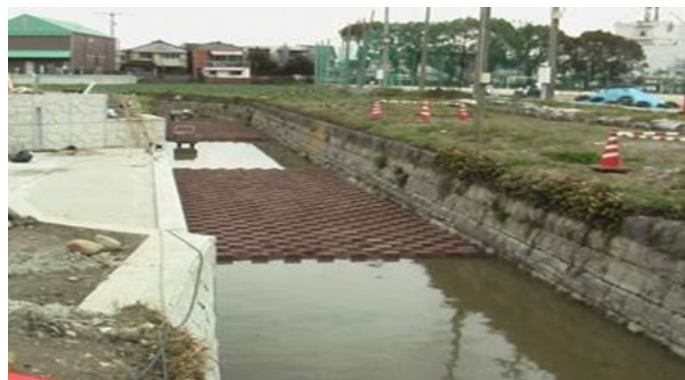
Đặt EBB ở mương thoát nước
