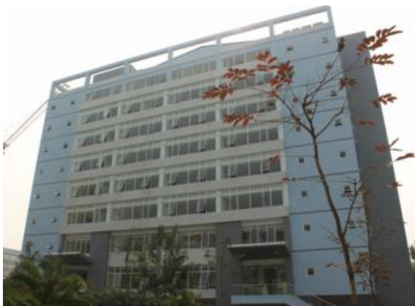
Tòa nhà đào tạo và dịch vụ
